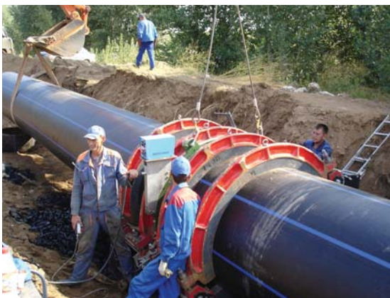
Рисунок 3. Применение сварочных машин с минимальной механизацией при сварке в стесненных условиях
