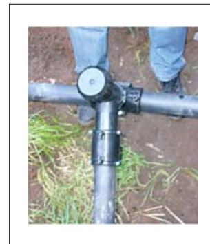
Рисунок 4. Врезка в действующий газопровод седелкой с закладными нагревателями
